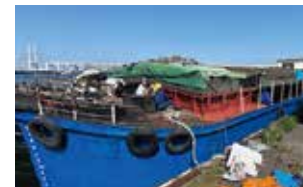
船体上部塗装作業
